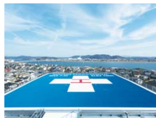
屋上ヘリポート
